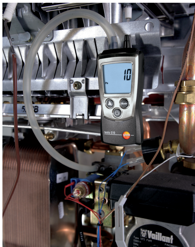
Citirea presiunii de racordare a gazului și a duzei pe instrumentul testo 510
