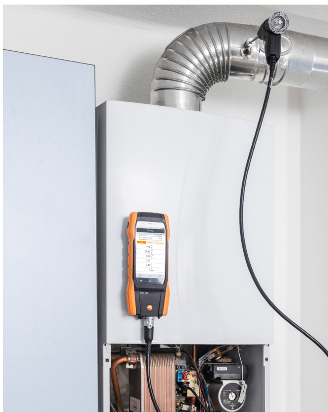
Un analizator de gaze de ardere, de ex., testo 300, este esențial pentru efectuarea setărilor
